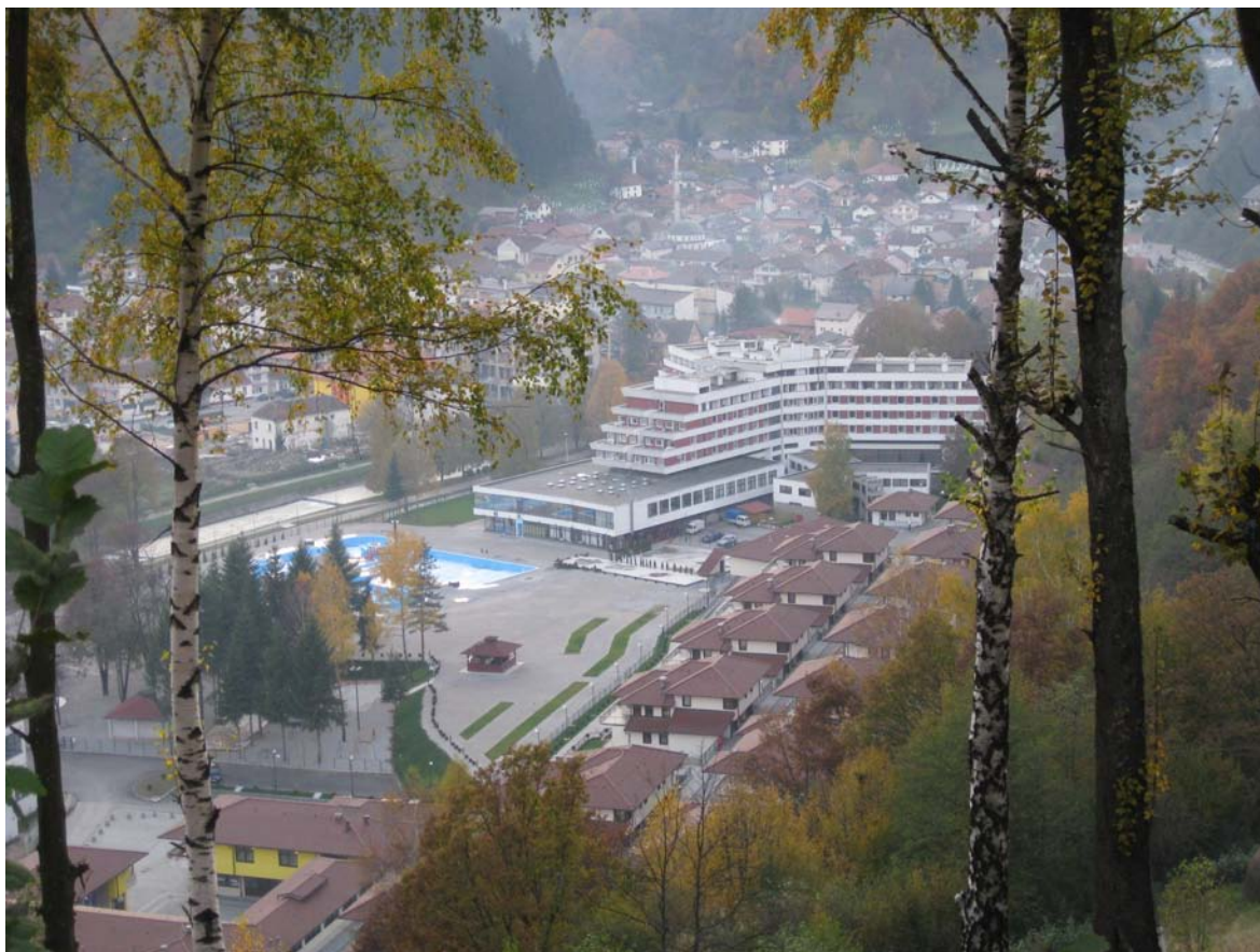
Les installations du centre Réumal à Fojnika : Centre thermal, hôtels, restaurants, villas et parc aquatique
